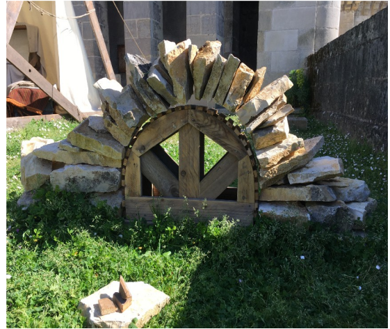
Ouverture coffrée en pierre sèche
