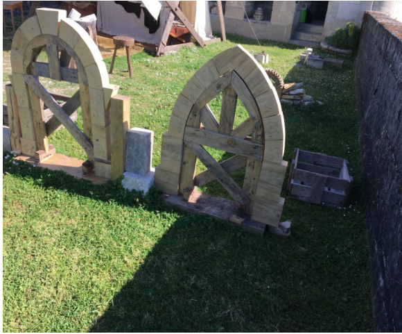
Ouverture plein-cintre et arc brisé
